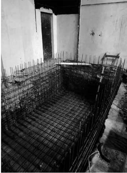
**Figura 53.** Construcción de la cisterna. Fotografía tomada por el autor. 27-06-17.
